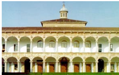
Sede centrale: cortile del Richini
