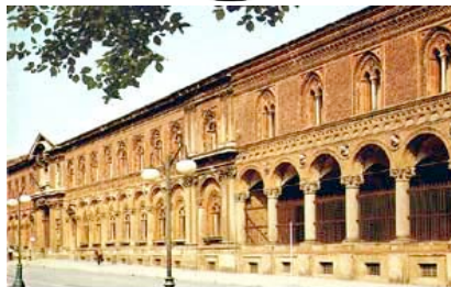
Sede centrale: facciata lungo largo Richini
